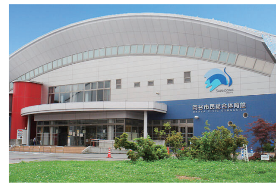
岡谷市民総合体育館(西体育館)
